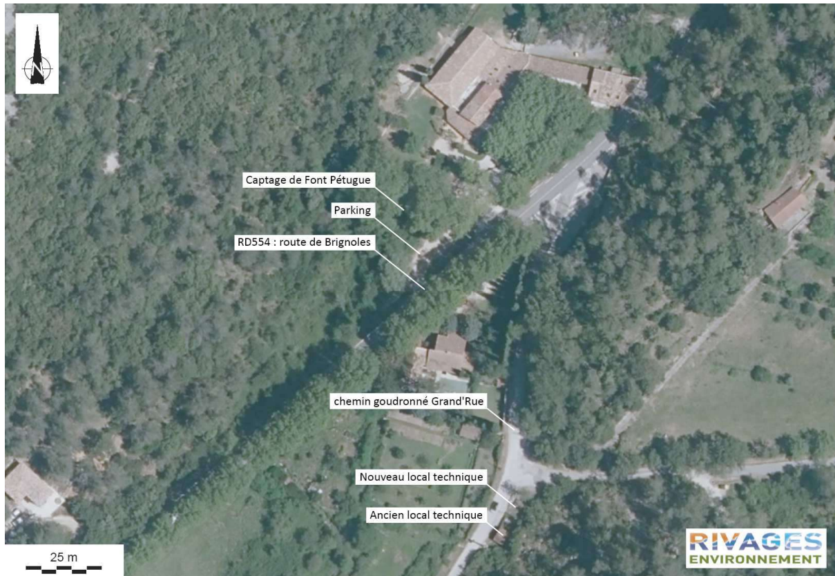
Figure 14. Localisation des installations de pompage (captage) et de traitement (nouveau local technique) relatifs à la source de Font Pétugue
